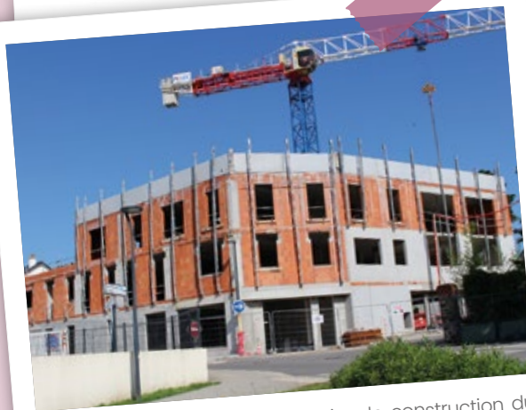
Peu de pause cet été au chantier de construction du futur Pôle Santé. Le bâtiment prend de la hauteur !
