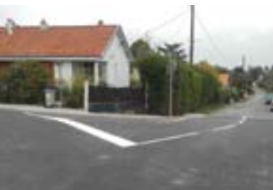
P.3. Le point sur les travaux
