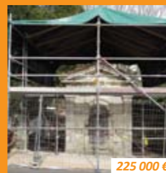
Restoration de la Fontaine Saint-Denis et de ses jardins - 225 000 €
