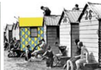
P9. Mauves Balnéaire
