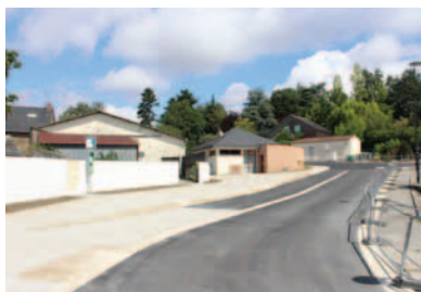
P.7. Les travaux de 2018
