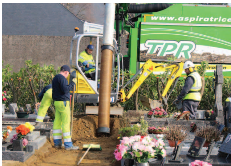
Les travaux réalisés au cimetière d'un montant de 343 636 € portent sur l'accessibilité ainsi que sur l'aménagement paysager.
