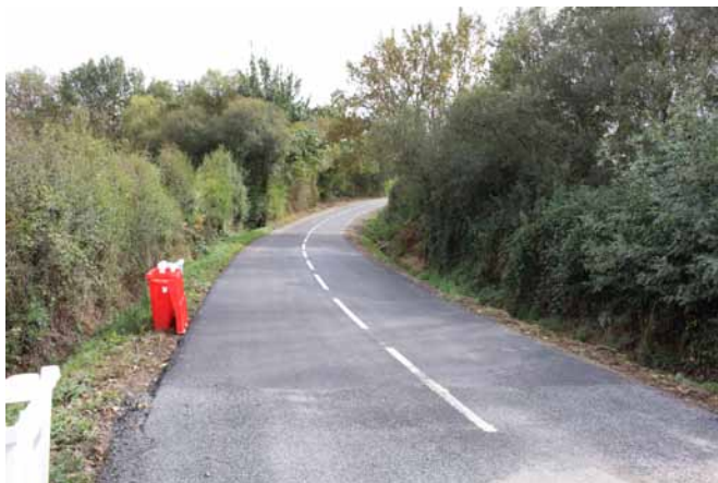
Route de Sucé-sur-Erdre
